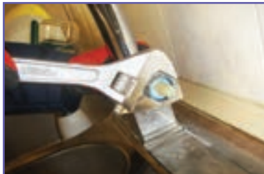
ث- باز کردن پیچ روی مغزی (گلند)
