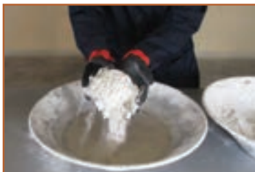
ب - اضافه کردن گچ به آب
